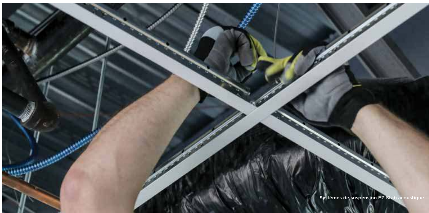
Système de suspension verrouillable Quicksan™ pour panneaux de gypse
